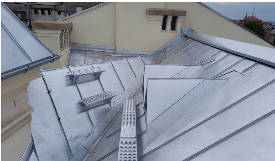
Rys. 8.3. Widok fragmentu dachu od strony południowo-wschodniej [19]
