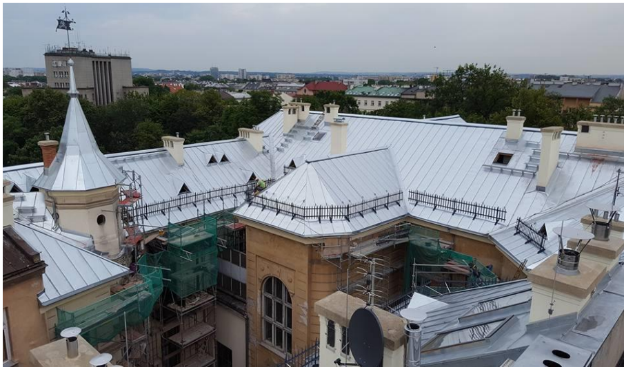
Rys. 8.1. Widok zrekonstruowanego dachu od strony południowo-wschodniej [19]
