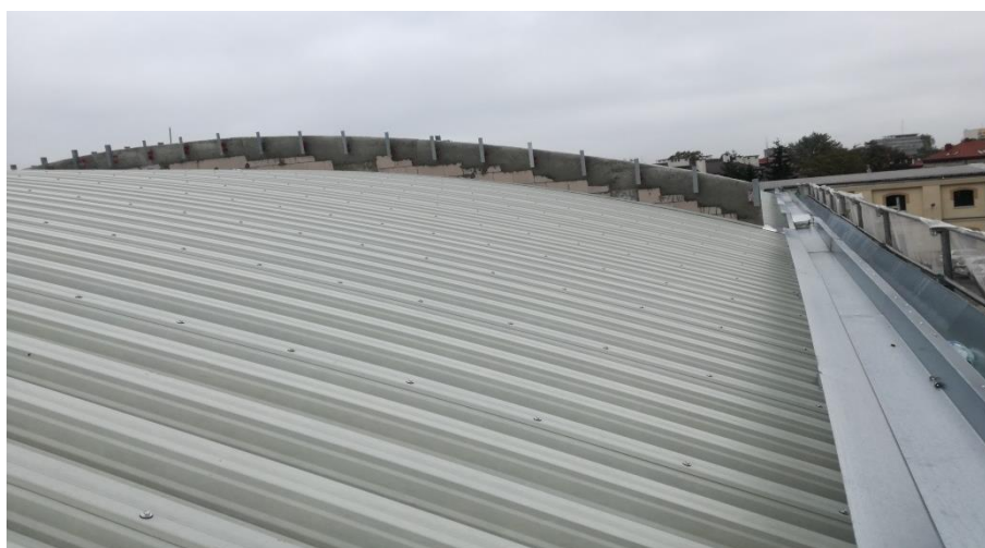
Rys. 8.4. Widok dachu z ułożoną warstwą nośną w postaci blachy trapezowej [18]
