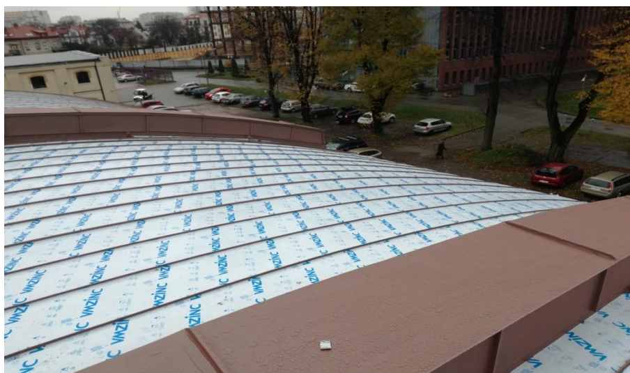
Rys. 8.7. Fragment połączeni dachowej przygotowanej do montażu pokrycia z blachy [18]
