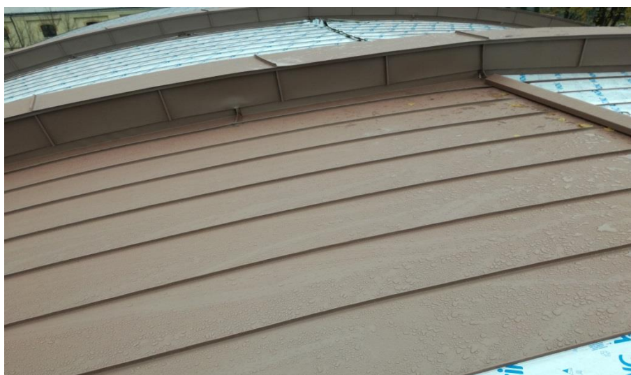
Rys. 8.8. Fragment połączeni dachowej z zamontowaną blachą tytanowo-cynkową (VmZinc Pigmento Red) [18]
