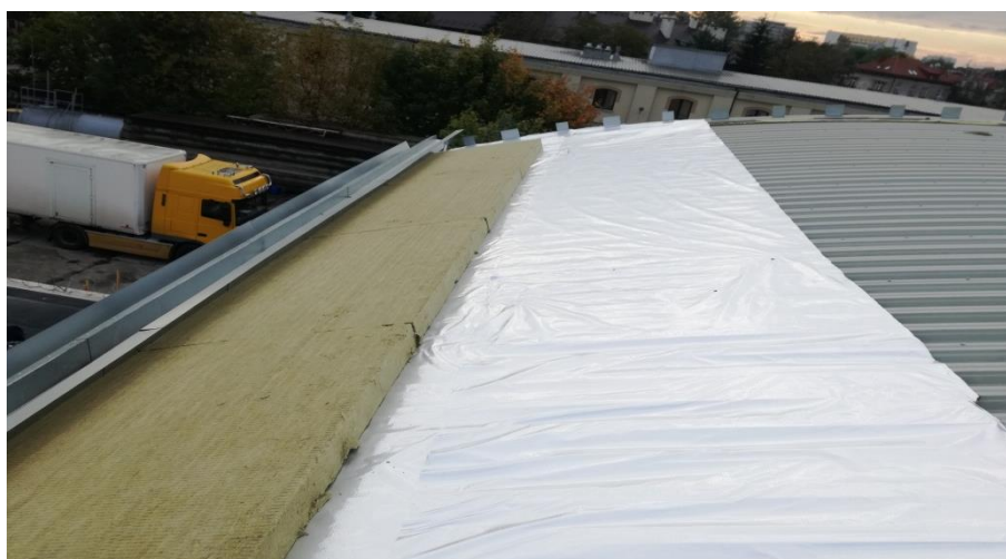
Rys. 8.5. Widok fragmentu dachu z ułożoną warstwą paroizolacji oraz pakietami twardej wełny mineralnej [18]
