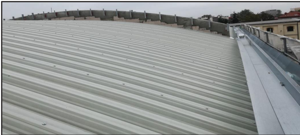
II. 28. Dach z ułożoną warstwą nośną w postaci blachy trapezowej
