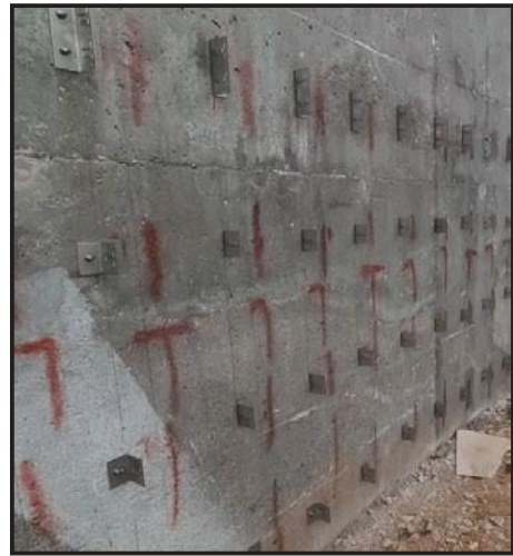
Il. 50. Wytrasowana ściana żelbetowa
