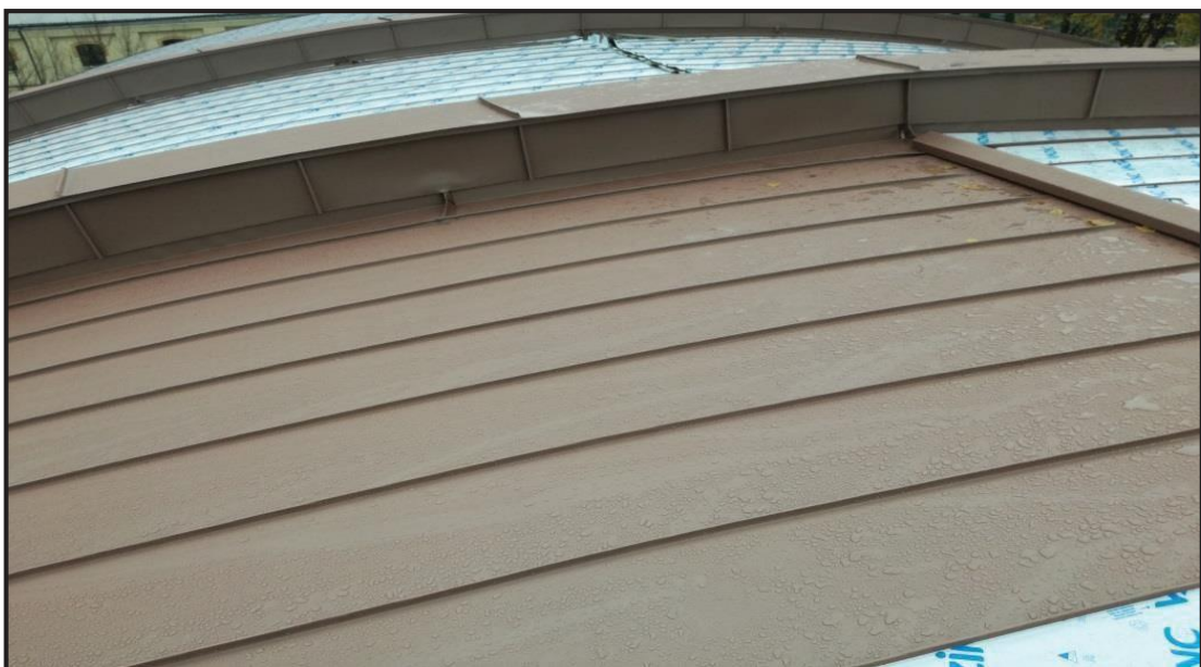
Il. 31. Zamontowana blacha na rąbek stojący, wykorzystująca zaczepy ZK-3/ZK4
