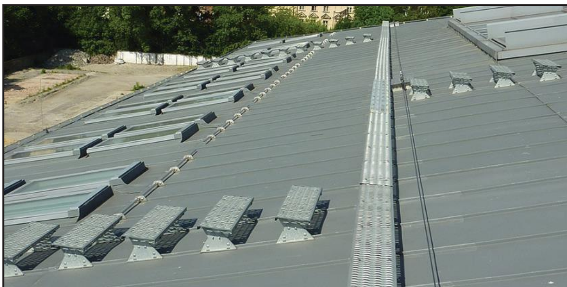
Il. 40. Komunikacja dachowa (ławy oraz stopnie kominiarskie)
