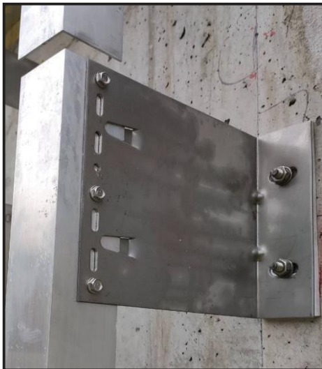
Il. 51. Konsola stała na podkładce z PCV
