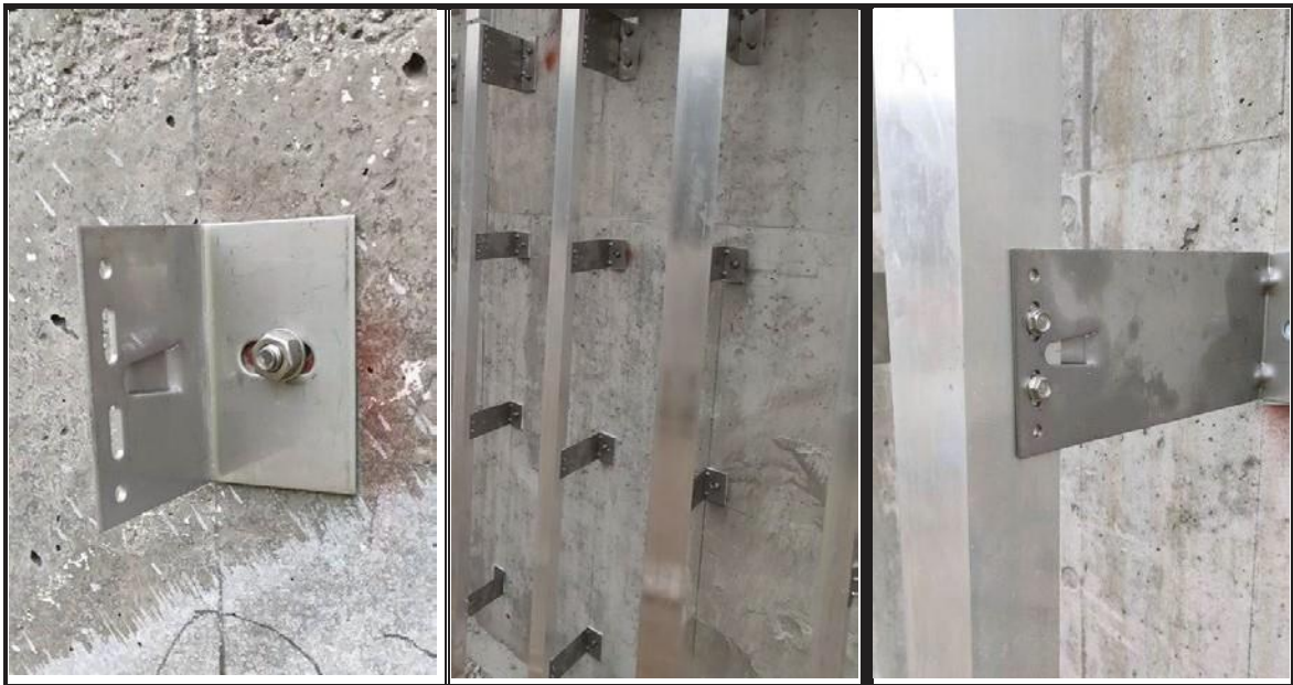
Il. 53. Profile ustawione na konsolach
