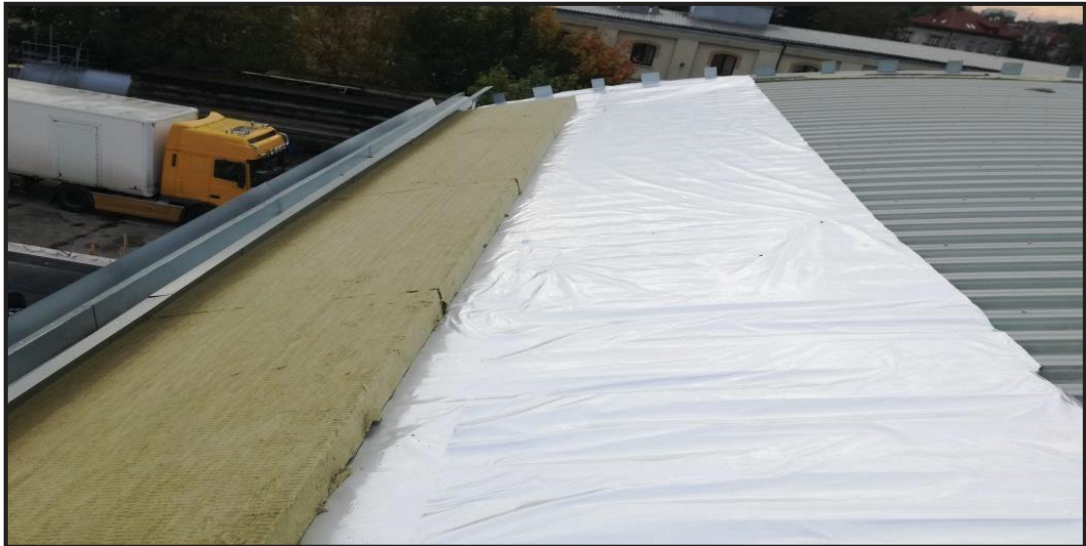
Il. 29. Ułożona warstwa paroizolacji wraz z pakietami twardej wełny mineralnej
